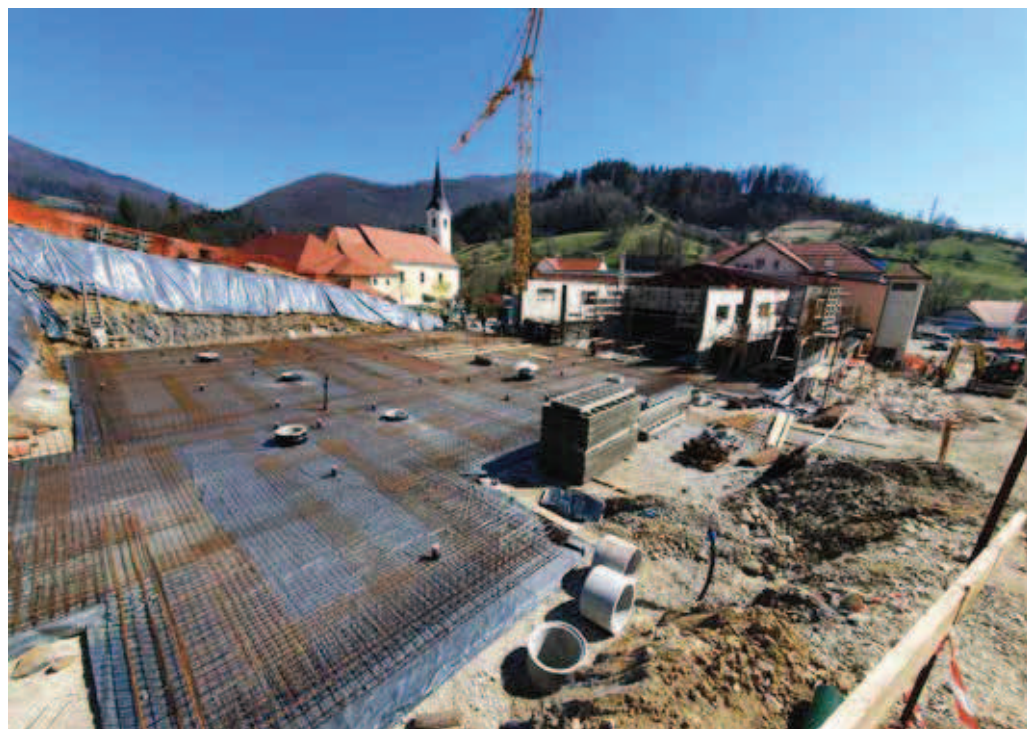
Izvedene stene odra, položena talna kanalizacija vrtca in izvajanje hidroizolacije pod talno ploščo
