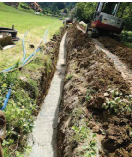
Vodovod Brdce - 2. faza
