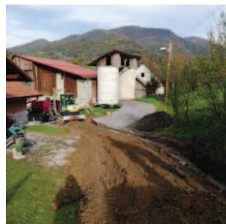
Gradbena dela na vodovodu Trnovlje pri Socki.
