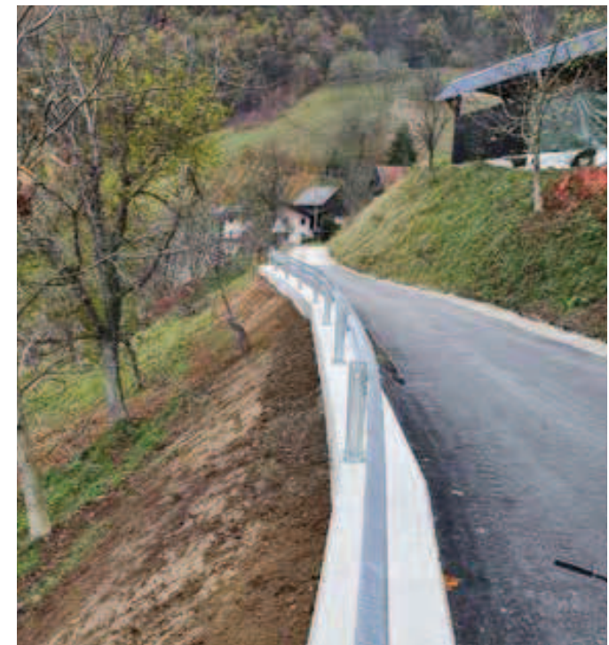
Obnovljeno cestišče nad plazom pri Špeglju
