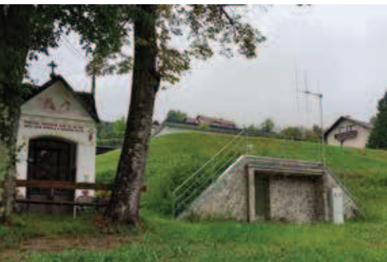
Izgradnja vodovoda Trnovlje pri Socki je končana.
