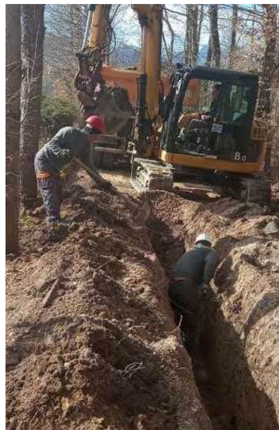
Izgradnja kanalov na projektu Aglomeracija Vojnik
