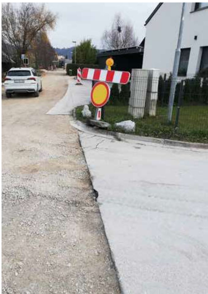
Pogled na Arclinsko cesto med gradnjo
