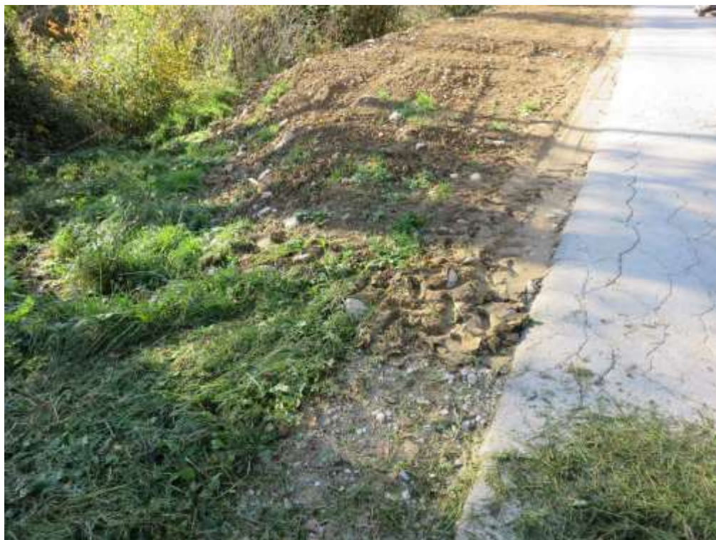
Slika 4: Nedovoljeno nasipavanje zemlje ob občinski cesti
