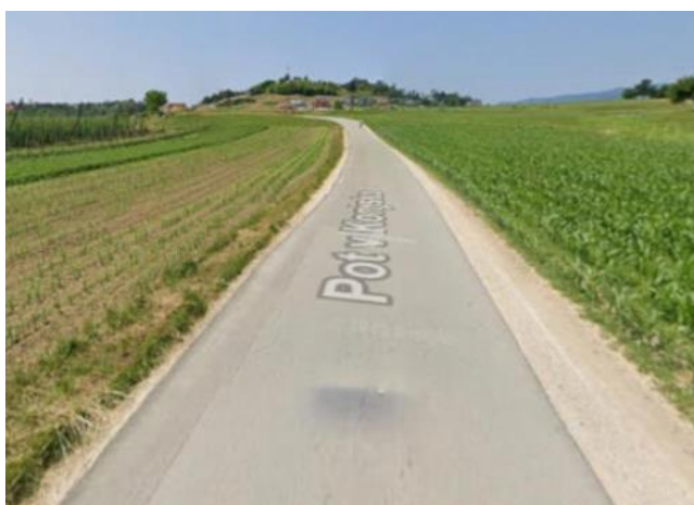
Slika 1: obstoječe stanje lokalne ceste LC-464091
