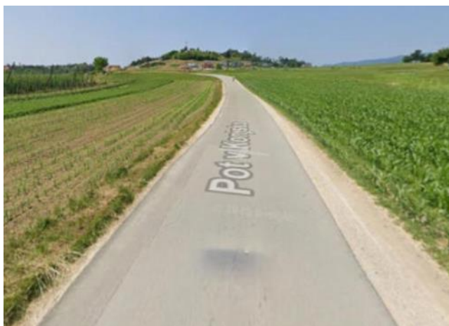
Slika 1: obstoječe stanje lokalne ceste LC-464091
